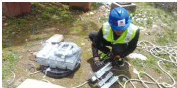
中国通信服务尼泊尔公司技术人员在 4G 测试站点施工
