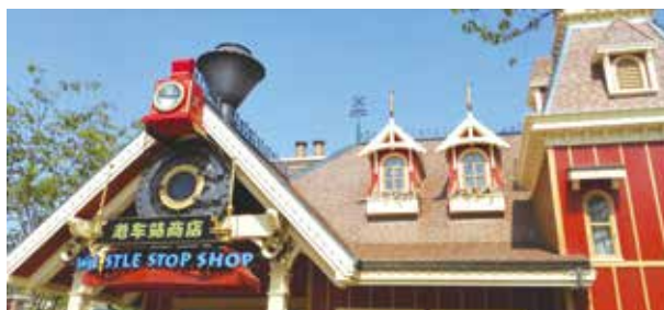
上海迪斯尼公园老车站商店屋顶安装定向定制化天线
